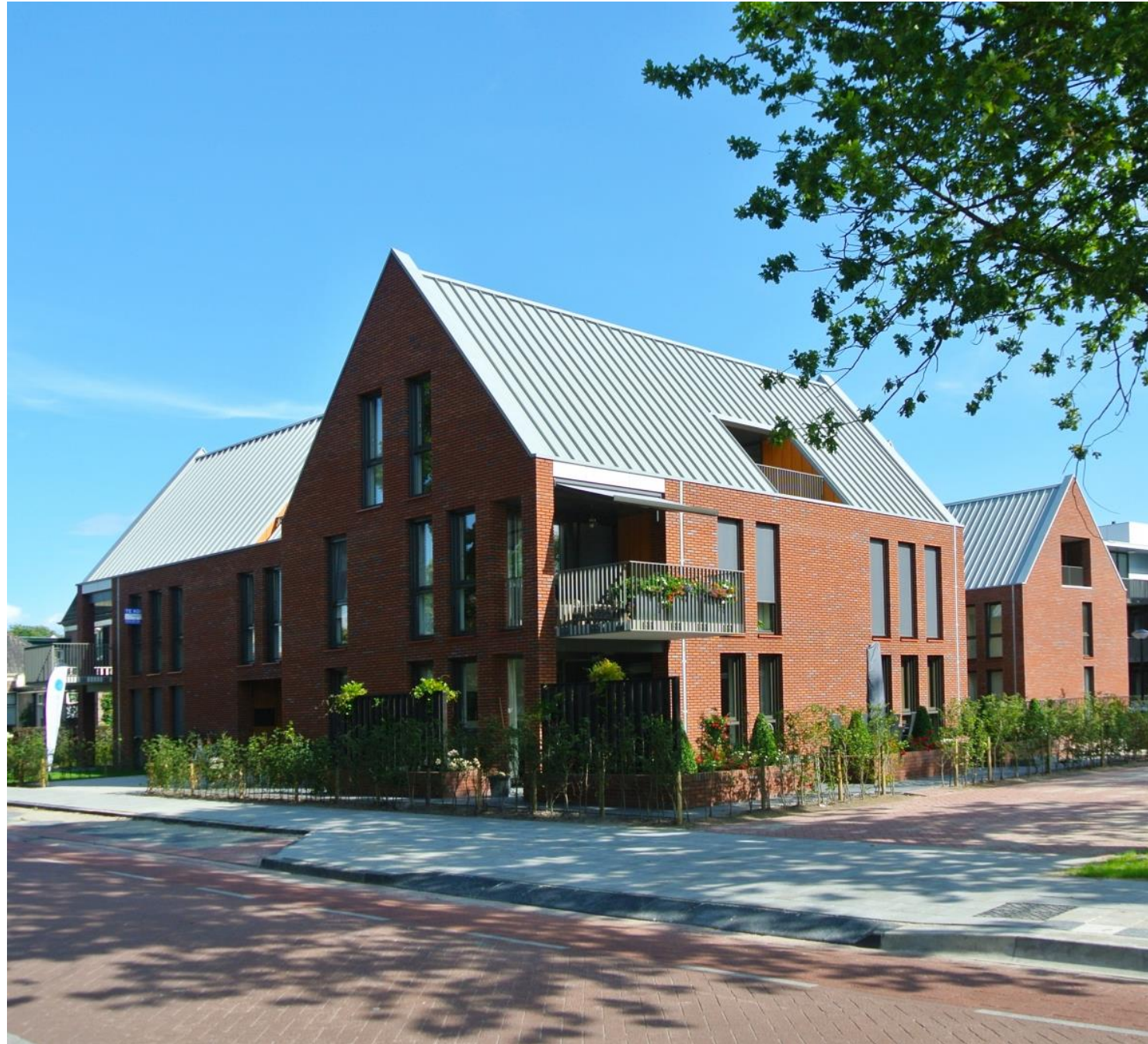
Appartementen 'Meerdorp' - Van Bokhorst Architecten
